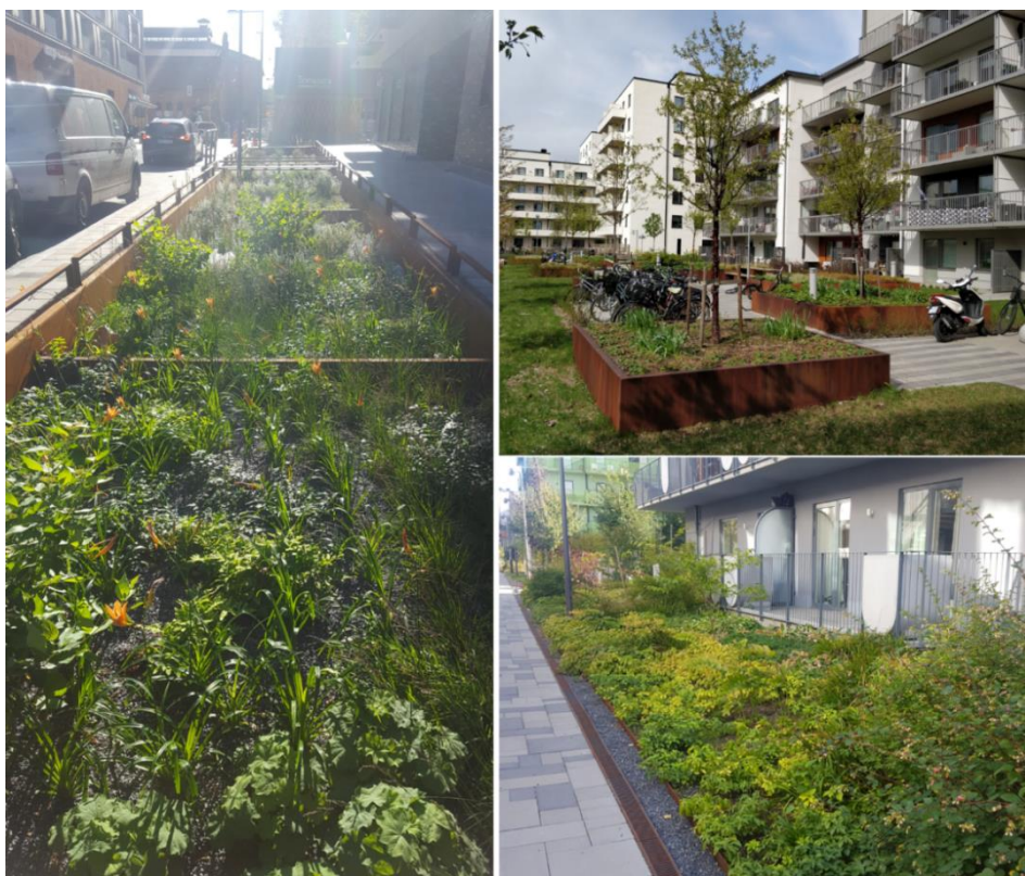
Figur 18. Till vänster visas en nedsänkt växtbädd på förgårdsmark i anslutning till lokalgata i Norra Djurgårdsstaden. Bilderna till höger visas växtbäddar i marknivå ovan bjälklag, den övre kommer från Östra Sala Backe och den nedre från Norra Djurgårdsstaden. Foto: Sweco.
