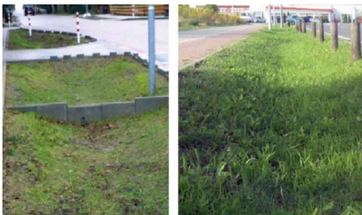
Figur 21. Exempel på hur gräsbeklädda diken kan utformas. Bilderna kommer från Stockholm Vatten och Avfall.
