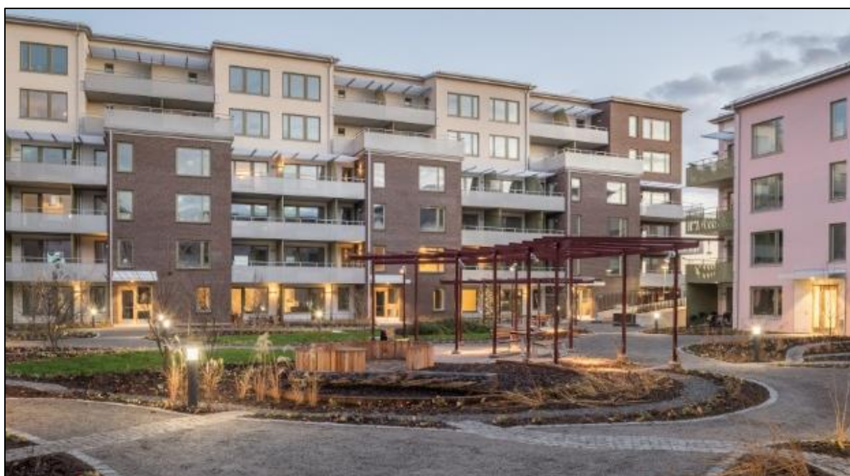
Figur 6-1. Avledning av takvatten till planteringar via rännदार anlagda i gatsten. Exempelbild från Linnéhuset i Uppsala (Källa: Uppsalahem).
