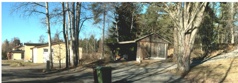
Figur 12. Förrådet i mitten av foto högst upp flyttas eller rivs då det är placerat på ett av natursläppen (Särsta 35:4), se Figur 2 för vyn nordöst om släppet. Fotot nertill: skärmtaket på garaget vänstra sida rivs då det ligger på föreslagen tillfartsväg (Nor 49:1).
