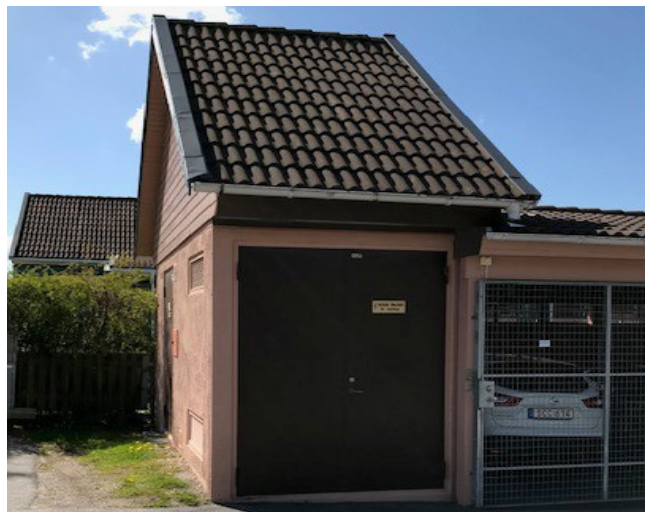
Transformatorbyggnad i bostadsområde. Husform som ansluter till områdets övriga byggnader. Foto: Per Lagheim
