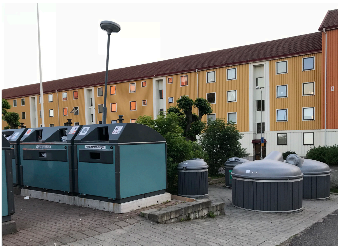
Bottentömmande behållare ovan mark (till vänster i bild) och underjordsbehållare med insatsäck (till höger i bild). FOTO:REBECKA JAKOBSSON, RAMBOLL.
